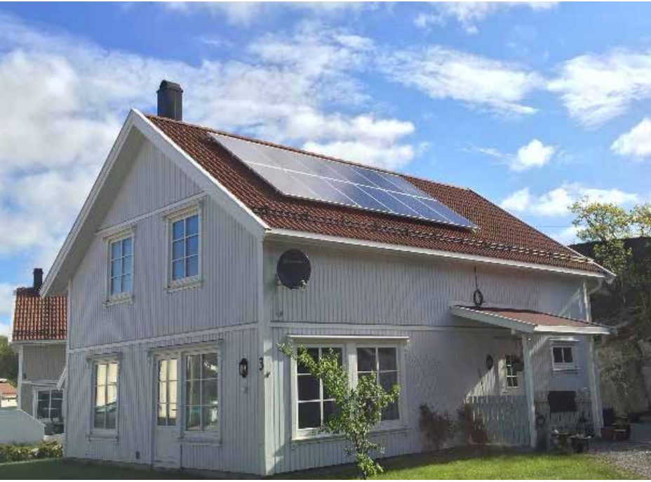
Solcellepaneler på bolighus.
