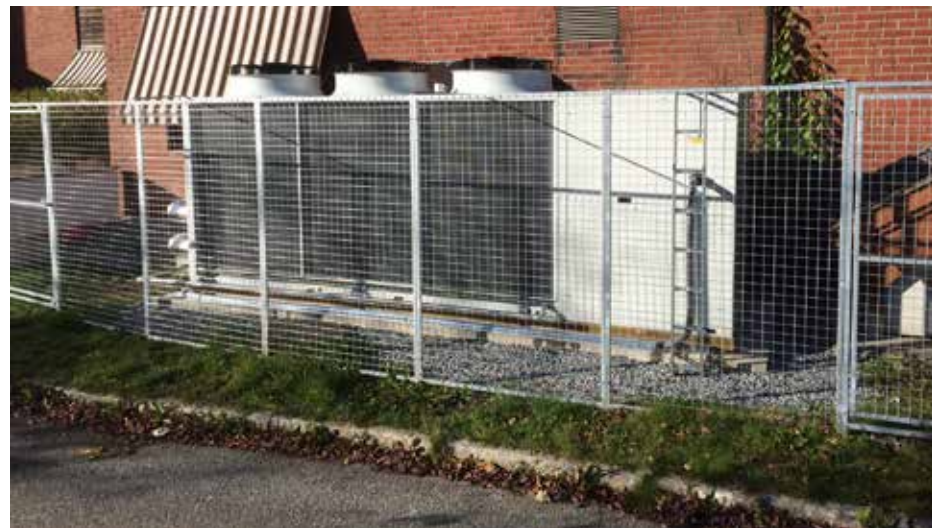
Luft til vann varmepumpe på Grinitun med effekt på 115 kW.
