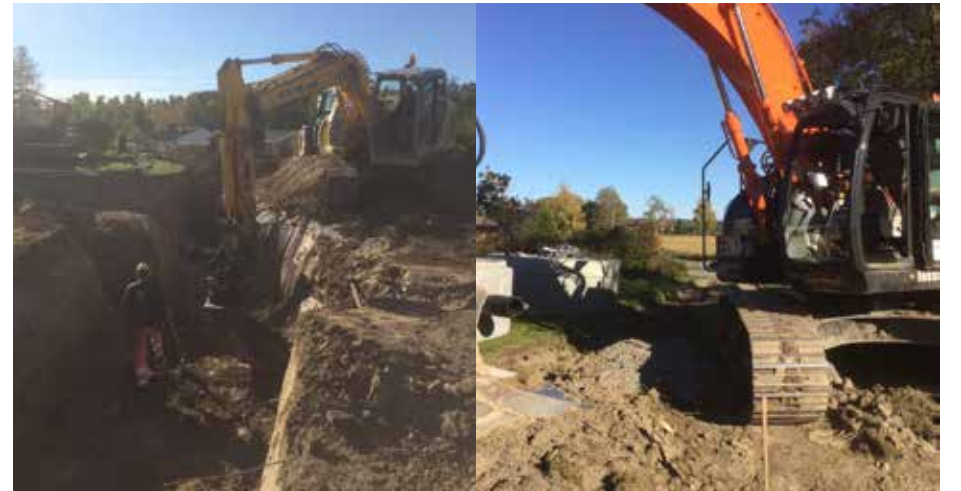
Plassering av målekum utenfor Glendeveien 58.
